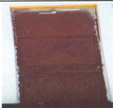
Foto 3: Mantenimiento de estructura a puerta de metal en módulo de aulas.
