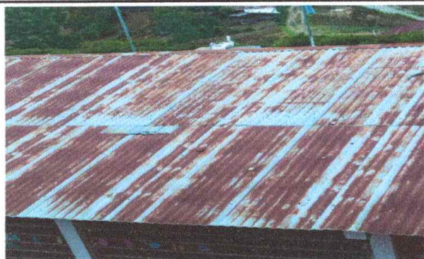
Foto 1: Sustitución de Lamina, por lamina troquelada Aluzinc calibre 26 modulo de aulas.
