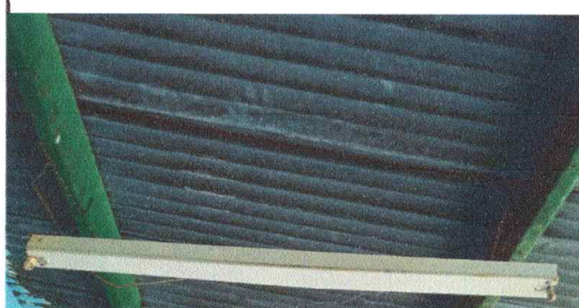
Foto 8: Reparacion de lamparas en módulo de aulas.
