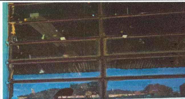
Foto 4: Sustitución de vidrios.
